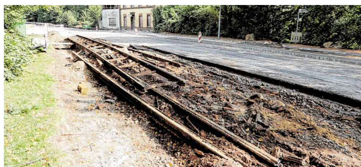
Bei den Bauarbeiten an der Rhenaniastraße tauchten im Untergrund unter dem Straßenbelag alte Gleise von der Straßenbahn auf. Foto: privat
